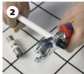
2 Калибровка и снятие фаски
